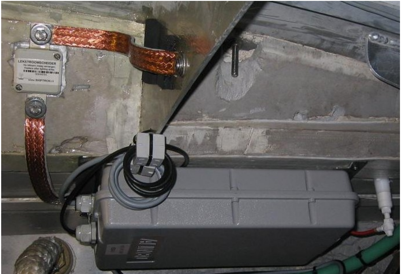
Figuur-6 Montage lekstroomscheider met koper-litze
